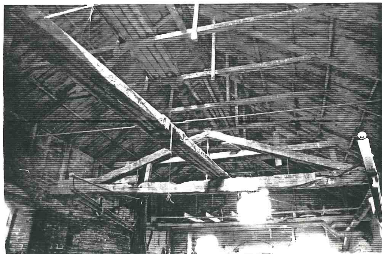
Smedjans takkonstruktion. I mitten, nedanför taklaget, en av de tre fasta traverserna som utgjorde bärkonstruktionen till lyftapparaturen.
